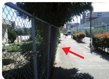
フェンスの倒れ
