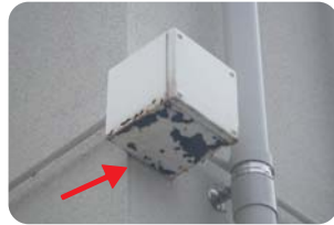
ボックスの錆
