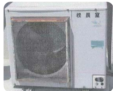
空調室外機からの異音
