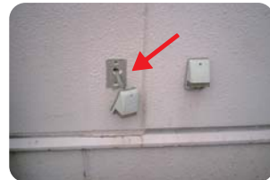
コンセントの破損
