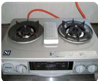
ガス器具からの異臭
