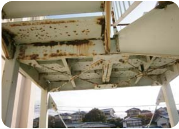
鉄骨階段の錆
