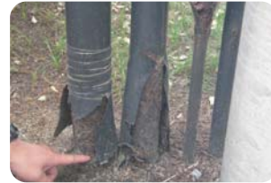
引込配管の錆、爆裂
