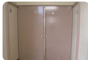
扉の開閉不良
