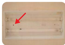
非常照明(表示灯ランプ)
