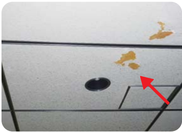
天井ボードの傷
