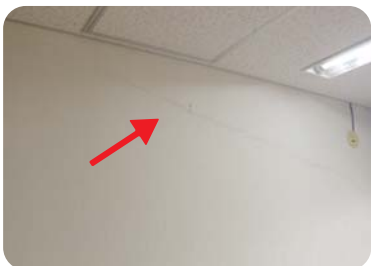
壁面のひび割れ
