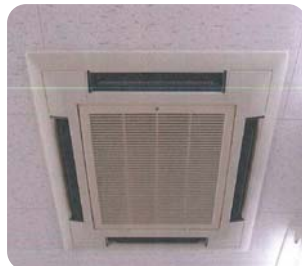
天井吹出しからの異臭
