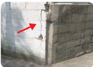
ブロック塀のひび割れ
