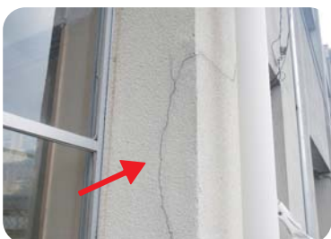
外壁のひび割れ
