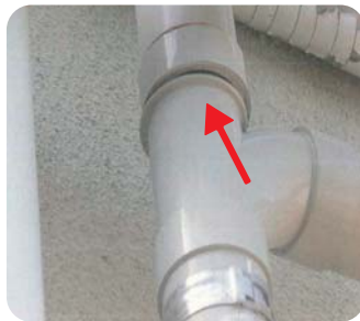
露出配管の伸縮破損
