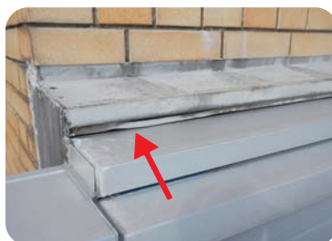
シーリングの切れ
