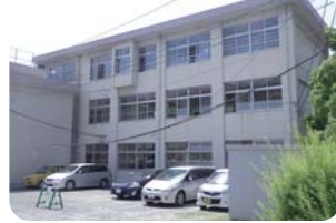
架空電線のたわみ
