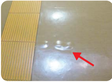
ビニール床シートの浮き
