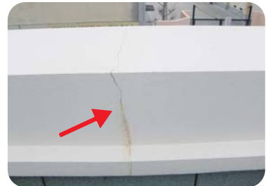
パラペットのひび割れ
