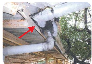
雨樋からの水漏れ
