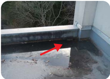
ルーフトレンの詰まり
