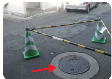
マンホール蓋の割れ
