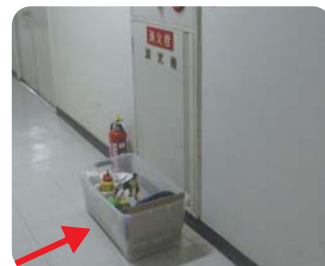
屋内消火栓前の障害物
