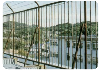
屋上フェンスの錆
