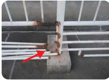
屋上手摺のぐらつき
