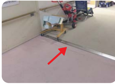
床カーペットの浮き
