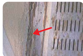
盤内への水の浸入
