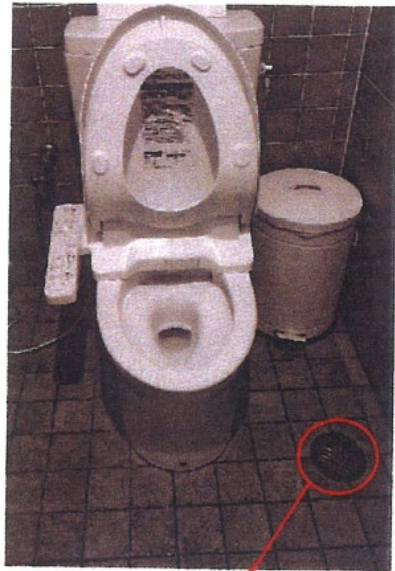
乾燥、破封の危険性(封水の補充が必要)(日本)
