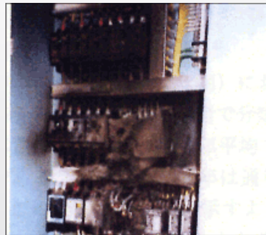
【分電盤への影響】 ※大電流による破壊
