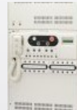
※起動用電源・制御用電源」
