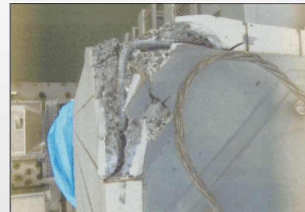
【雷撃によるコンクリート破壊】
