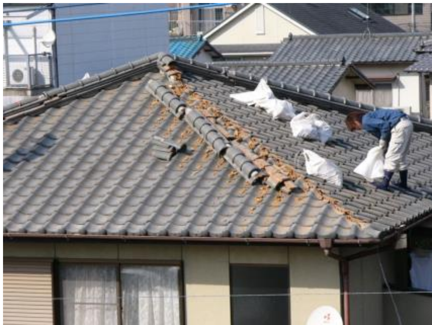
屋根瓦の被害
