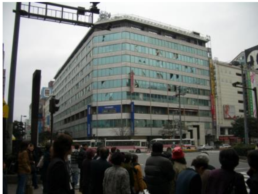
ガラスの破損落下
