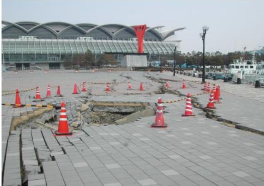
地盤の液状化被害
