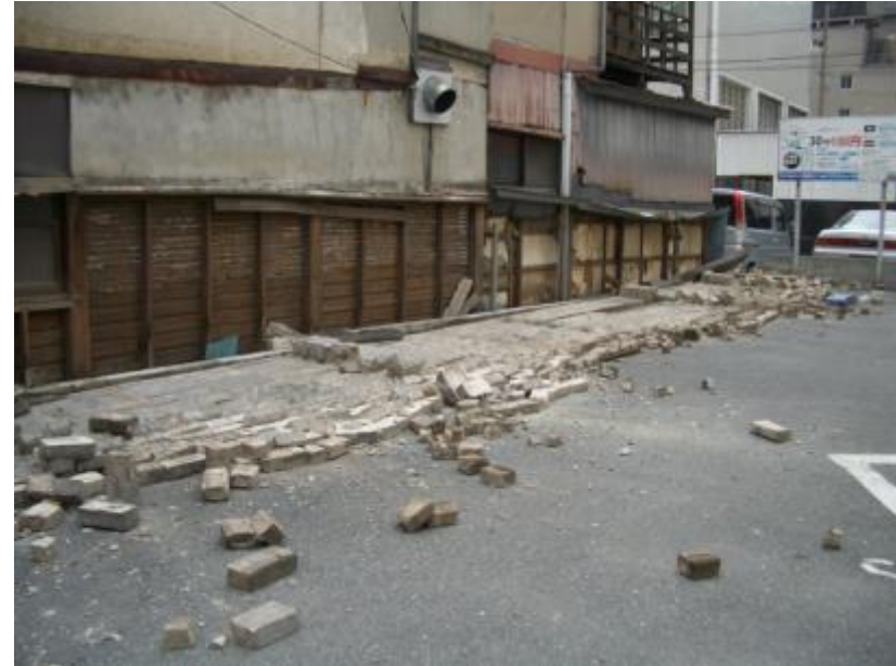
ブロック塀の倒壊
