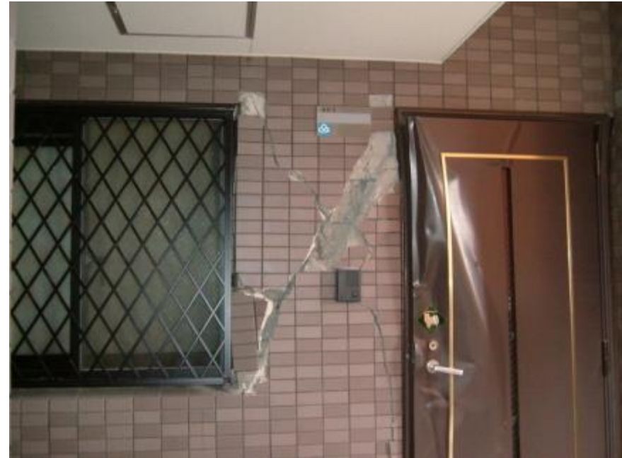
非耐震壁の被害 (ドアが開かない)
