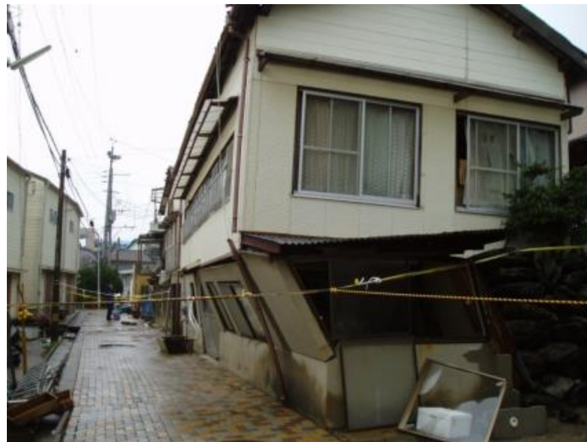
1階部分の倒壊
