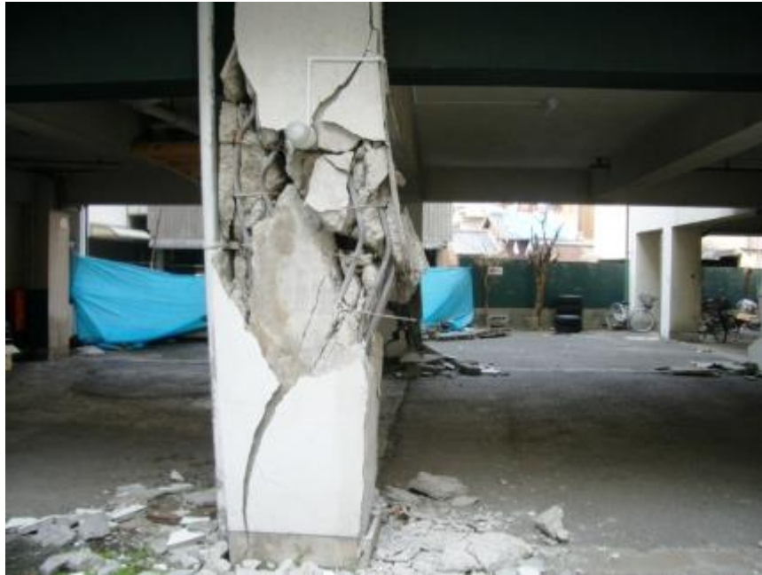
マンション1階柱の被害 (ピロティ柱)
